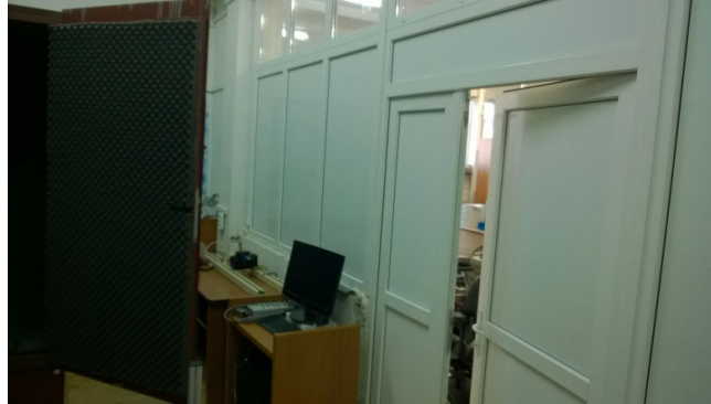
Figura 5. Peretele despărțitor din termopan (dreapta) și intrarea în încăperea de testare fonică a motorizării de mare viteză (stânga).
